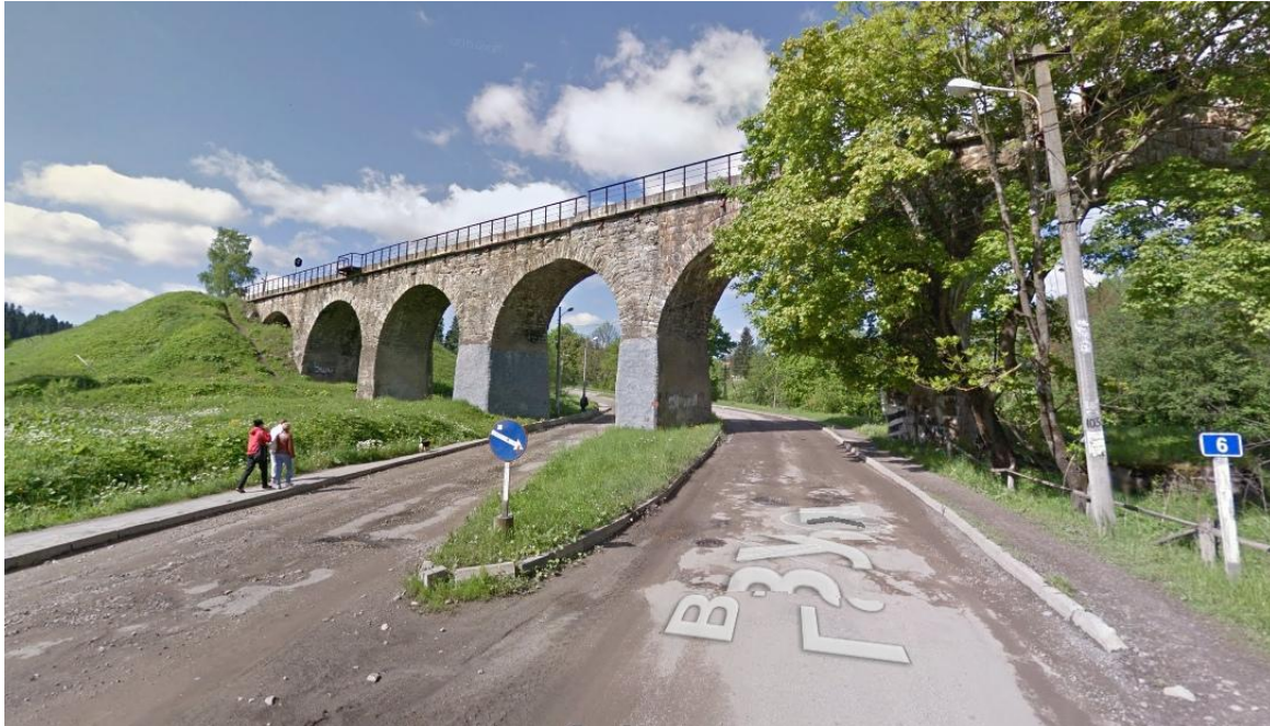
Зразок направляючого острівця навколо опори залізничного шляхопроводу в селищі Ворохта на автодорозі Р-24
